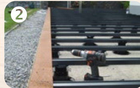
TERRASSEN AUFBAU Der Unterbau ist für eine dauerhafte Terrasse ausschlaggebend.
